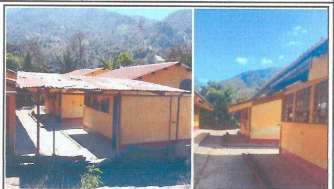
Foto 2: Necesidad de mejora con techo Lamina troquelada cal. 26 en Portico de Ingreso, entre 2 Aulas Laterales y Area del fondo.
